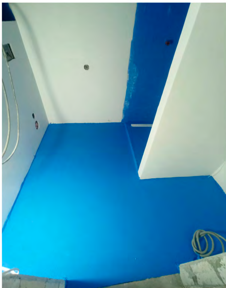
ГИДРОИЗОЛЯЦИОННЫЕ РАБОТЫ
